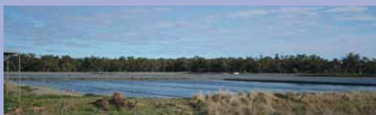
Bogan effluent reuse
